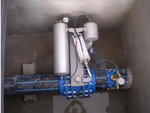
Figura 8. Actuador hidráulico para válvulas de mariposa
